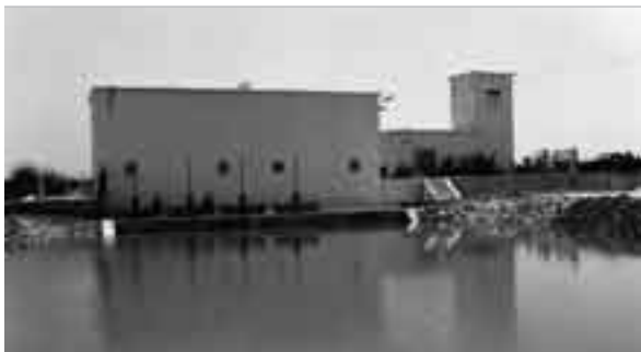
Toutes les eaux de drainage du périmètre de Boundoum se joignent à la station de drainage de Gaëla (photo) pour être évacuées dans le drain de l'émissaire du delta du fleuve Sénégal. (Photo : Madine Ndao, CIC/SAED)
